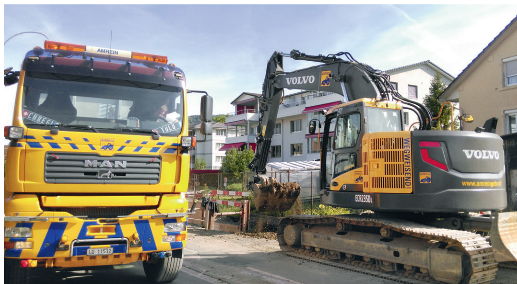
Die modernen Baumaschinen der Amrein Gebr. AG garantieren eine rasche und reibungslose Dienstleistung.
